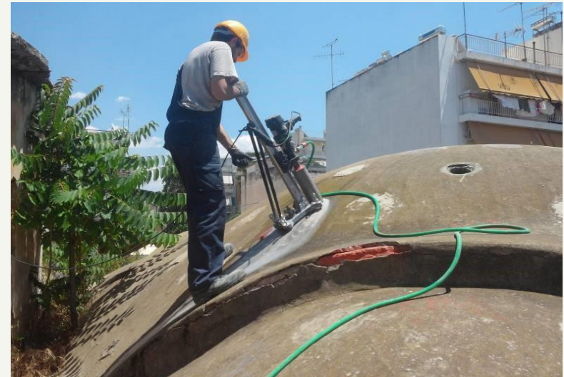
Λήψη κυλινδρικού δοκιμίου σκυροδέματος από θολωτή πλάκα
