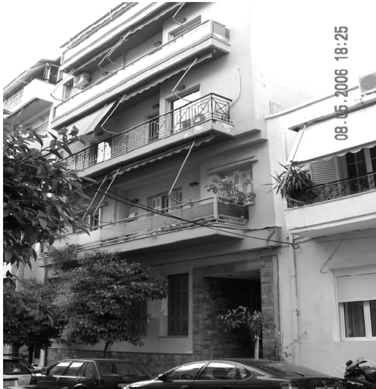
Σχήμα 2. Τετραώροφο κτίριο σε Καλλίπολη Πειραιά κατασκευής 1979
