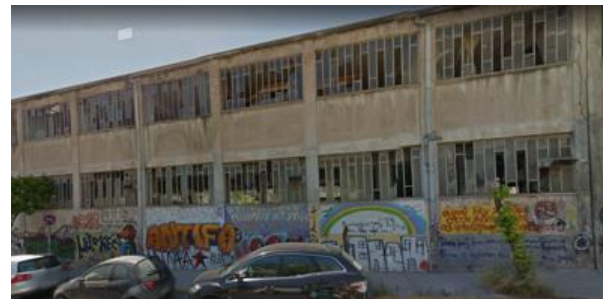
Εικόνα 4: Κτίρια 10 & 11 - Ύπαρξη κοντών υποστυλωμάτων λόγω διακοπής τοιχοπληρώσεων
