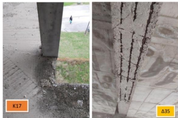
Εικόνα 2: Κτίριο 6- Κακοτεχνίες, Αποτίναξη επικαλύψεων
