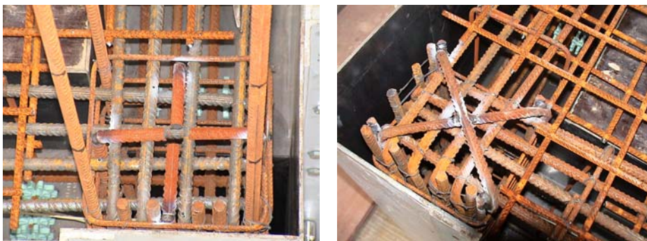
Σχήμα 1. Λεπτομέρεια αγκύρωσης του κυρίως οπλισμού των κολώνων στο πάνω μέρος των κόμβων του κάθε ορόφου.
