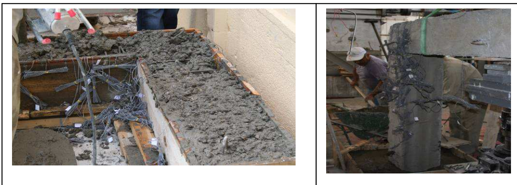
Σχήμα 2 Σκυροδέτηση δοκιμίου και βάσης
